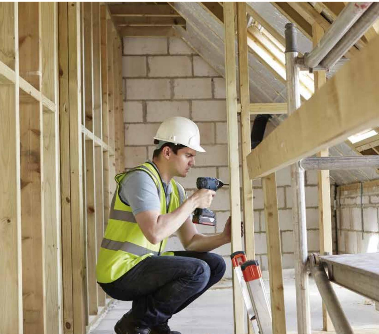
防护装备说明：保护人体头部，防止受坠物及其他特定因素引起的伤害的个体防护装备。常见装备有安全帽，除防砸、防穿刺功能外，还可以包含防静电、阻燃、电绝缘、侧向刚性、耐低温等一种或多种特殊功能。
